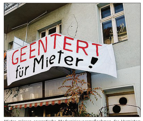
Mieter müssen energetische Modernisierungsmaßnahmen des Vermieters hinnehmen. FOTO DAPD
